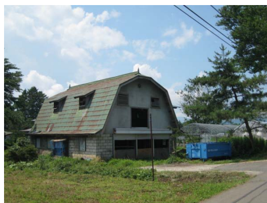
マンサード畜舎
