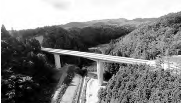
写真2 三陸沿岸道路(南三陸道路)立沢橋(2017年11月)
