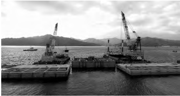
写真6 釜石港湾口防波堤の最終函据付状況 (2017年11月)
