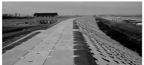
写真5 海岸堤防完成状況(2017年3月)
