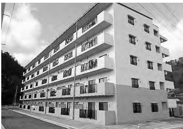
写真4 災害公営住宅(岩手県宮古市)
