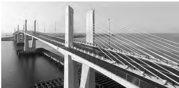
写真7 小名浜港東港地区臨港道路 (小名浜マリブリッジ)完成 (2017年3月)
